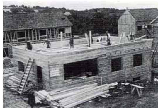
Figura 31. Sistema bloque llano, vivienda No. 19, bajo construcción, 1933.
