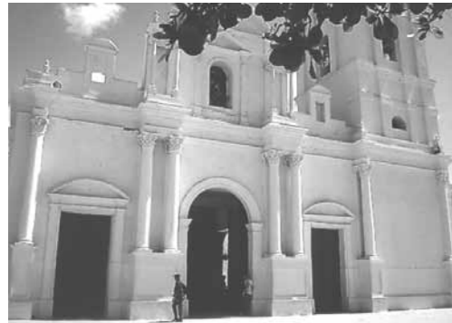
Órdenes neoclásicos en la fachada de la iglesia (Fotos: Alumnos de la Especialización en Patrimonio, Corporación Universitaria de la Costa, CUC).
