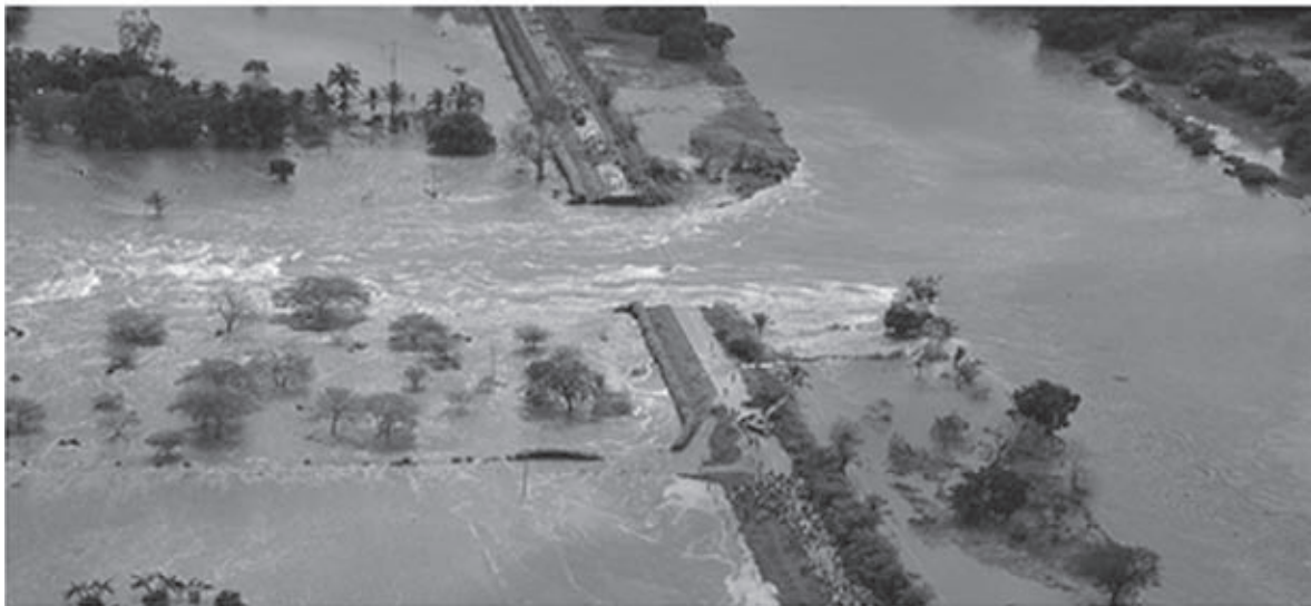
Foto 2. Canal del dique
