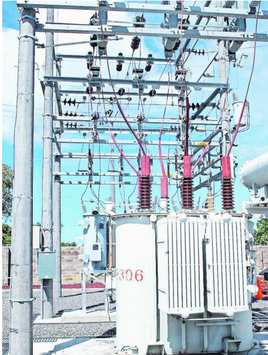
FIGURA No. 1 Planta Generadora
