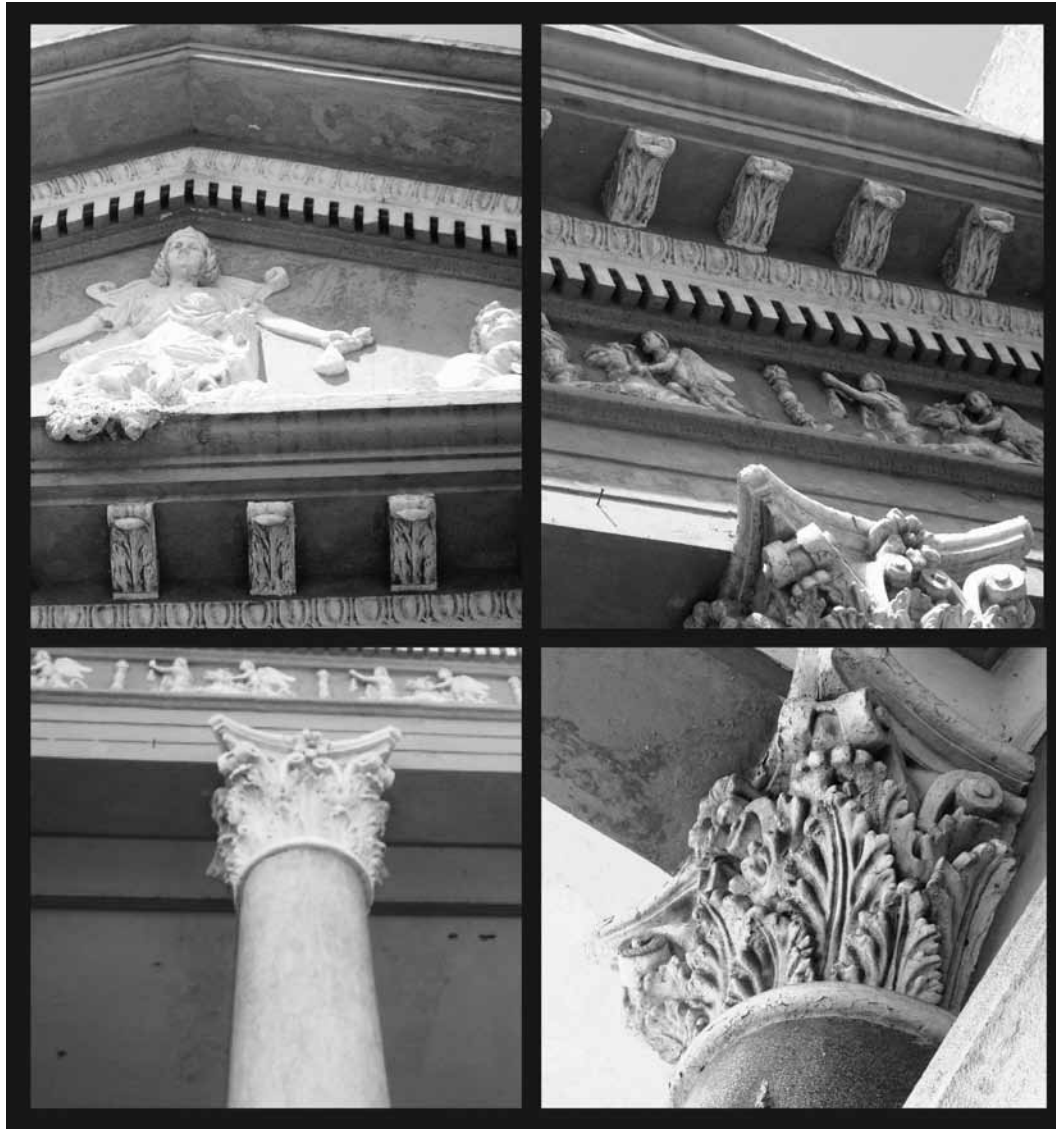
Detalles ornamentales del edificio Banco Comercial. Fotografías: Rossana Llanos.
