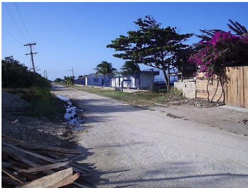
ACCESO A BOCAS DE CENIZAS
