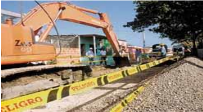
Maquinaria pesada fue trasladada a La Playa para Instalar las redes de alcantarillado faltantes. El sistema debe estar listo en marzo.
