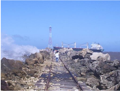
VISTA TAJAMAR ZONA FINAL
