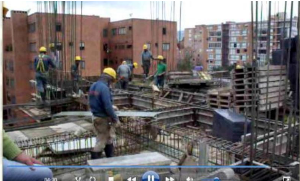
Figura 1. Captura de video de colocación de formaleta. Adaptado de “Mejoramiento de procesos constructivos de una edificación a partir de la simulación digital y videos Time Lapse” Por J. Echeverry y M. Giraldo, 2012.
