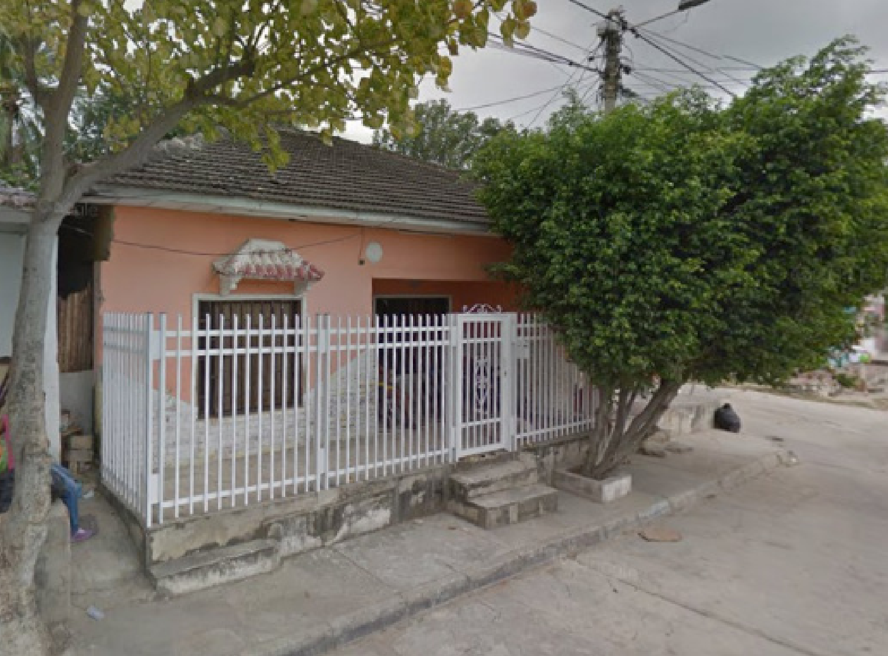
Fig. 4. Espacio público (andén) invadido en el municipio de Puerto Colombia.
