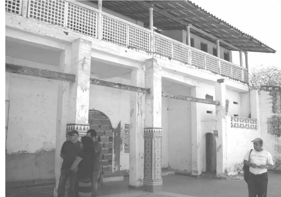
Foto 14. Vista de la terraza marina, en la que se aprecia su estado actual y la terraza mirador de la segunda planta. Las columnas de base cuadrada se enchaparon hasta una altura de 1,80 mts. Con mosaico de cemento y motivos ornamentales inspirados en la decoración árabe, en la parte posterior del inmueble, la cubierta superior fue reemplazada por láminas onduladas de asbesto cemento. Algunos vanos han sido tapiados de manera burda, y tanto la mampostería como las columnas presentan problemas patológicos, por el tiempo y la falta de mantenimiento. Ver detalles en las siguientes fotografías. Foto archivo del grupo de trabajo.
