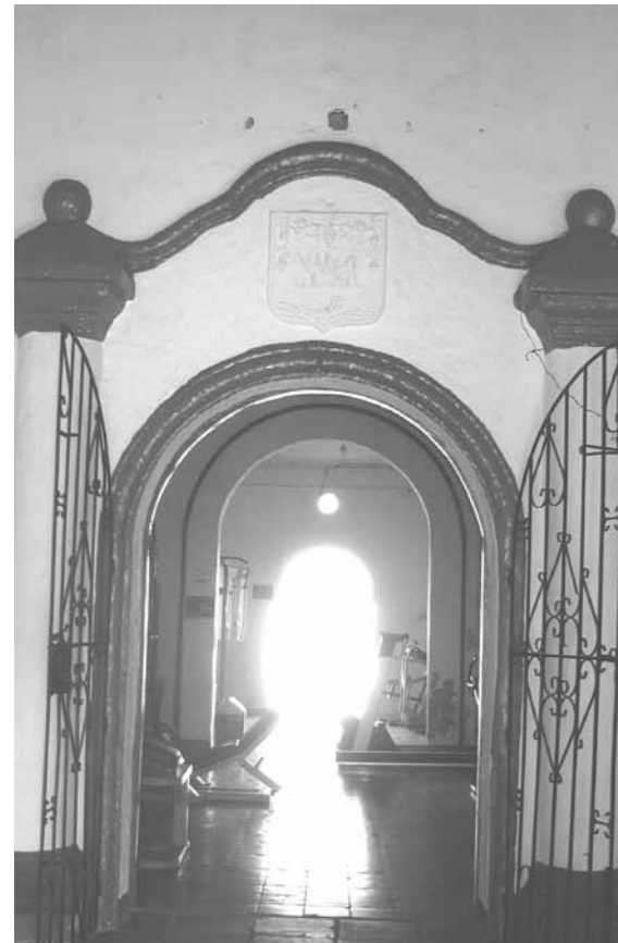
Foto 11. Primer plano de la portada de influencia española, en el acceso al lobby del hotel, visto desde la terraza de llegada. En la parte superior se observa una placa a modo de escudo heráldico del hotel. Ver detalle en la fotografía siguiente. Foto archivo del grupo de trabajo.
