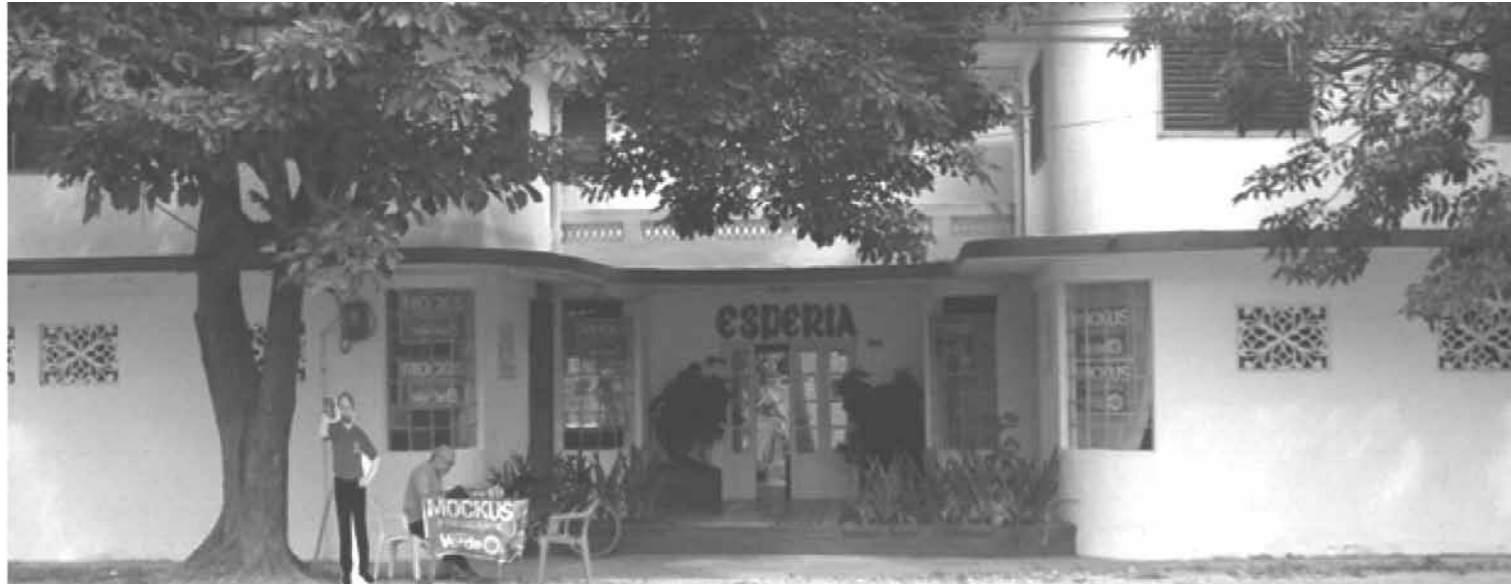
Foto 25. Vista frontal del acceso principal a la edificación. La planta del edificio presenta una forma de "C" alrededor de la terraza de llegada. La influencia del Art Decó es visible en el alero plano del primer piso, muros curvos y ventanería metálica con módulos rectangulares de vidrio, acoplándose a la curva del muro, en el primer piso. La ventanería del 2º piso, zona de habitaciones, tiene persianas horizontales en madera, a la usanza de la época. La cubierta del hotel aún conserva las tejas planas de barro cocido. Foto archivo del grupo de trabajo.
