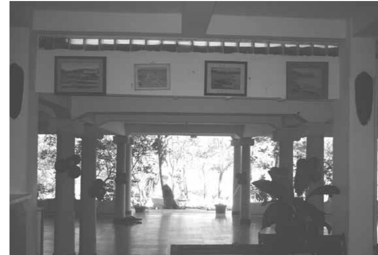
Foto 28. Vista del lobby del hotel, con columnas cilíndricas con amplios zócalos en mosaico de cemento, de inspiración Art Decó, y capiteles de influencia republicana, que soportan a las vigas descolgadas que sustentan el 2º piso. Al fondo, donde hoy se observa vegetación, estaba la playa y un acceso a una terraza marina, construida a la manera de palafitos, en el mar. Foto archivo del grupo de trabajo.
