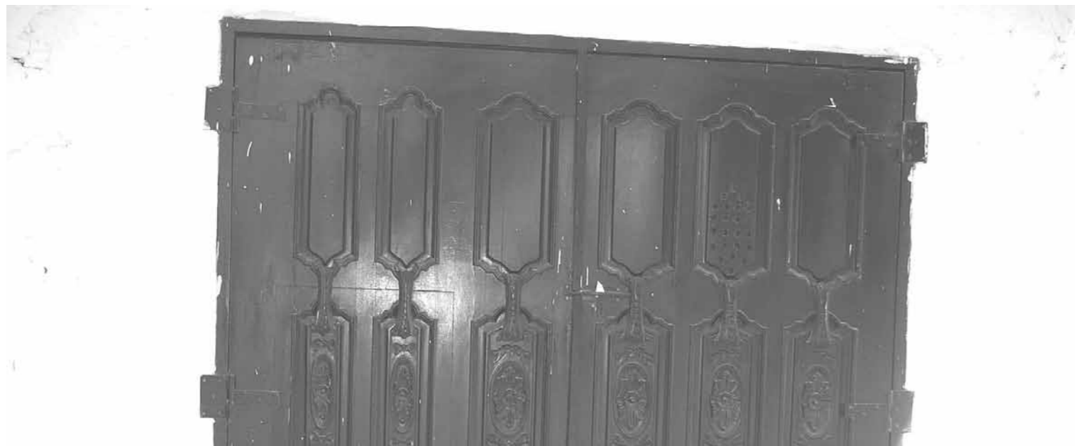
Foto 32. Vista de las puertas molduradas de acceso al garaje del hotel. Foto archivo del grupo de trabajo.
