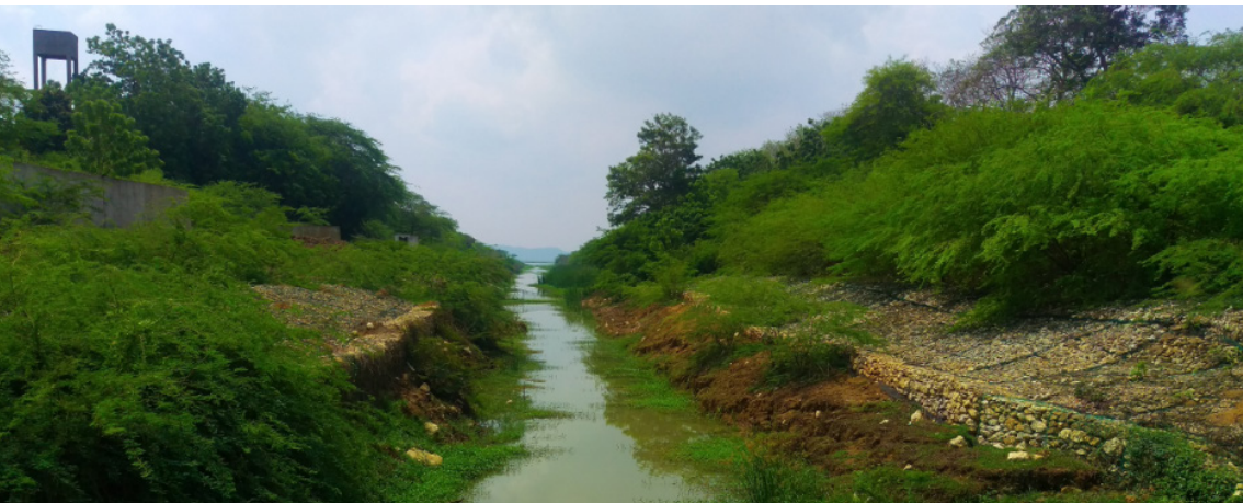
Figura 3. Canal de aducción, Repelón.
