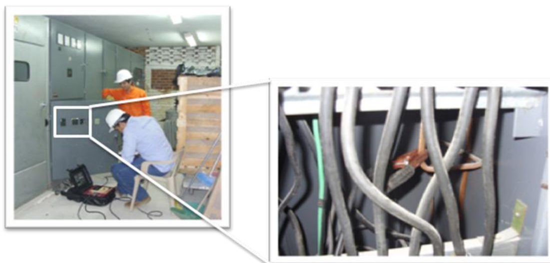
Figura 28. Mediciones de equipotencialidad.
