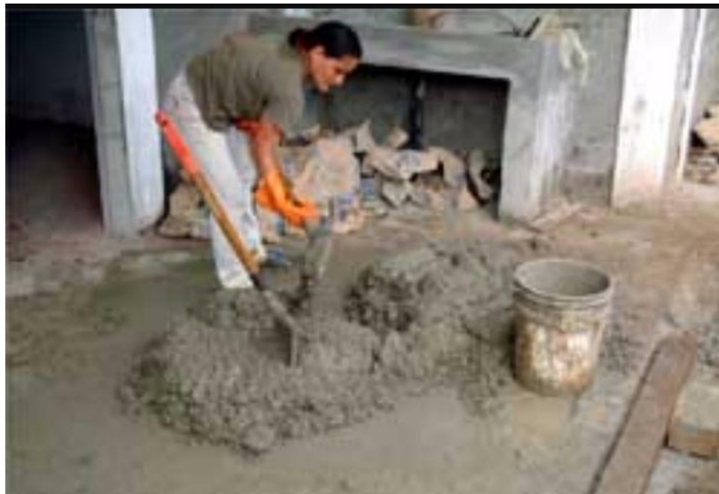
Ilustración 2. Mezclado manual. Fuente: mezcla en el sitio, guiasconcreto.mex.tl
