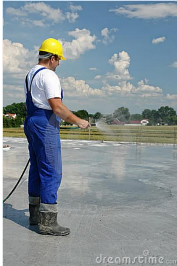
Ilustración 5. Curado del concreto. Fuente: Curado del concreto en obra, CivilGeeks.com
