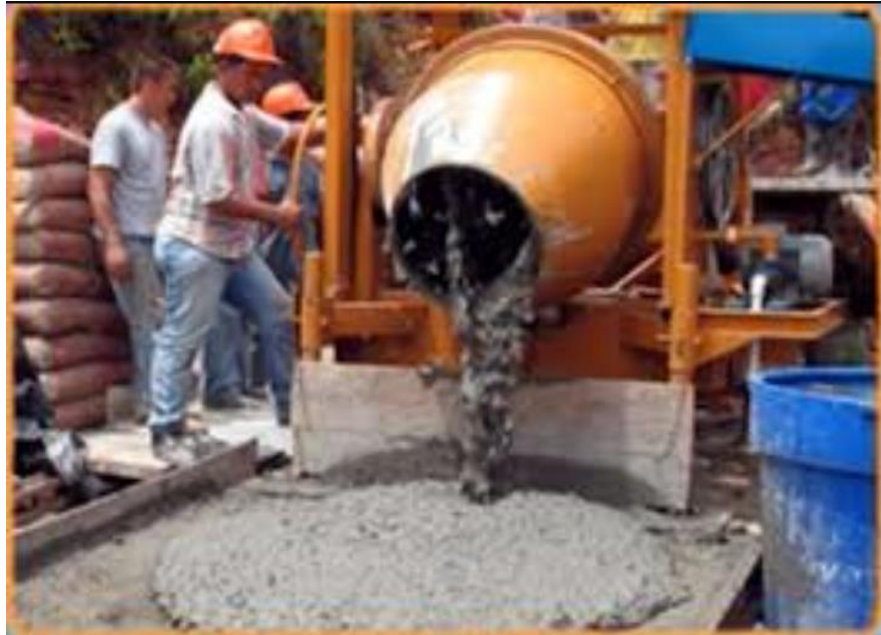
Ilustración 3. Mezclado mecánico. Fuente: Consideraciones en el Mezclado del Concreto, Civilgeeks.com
