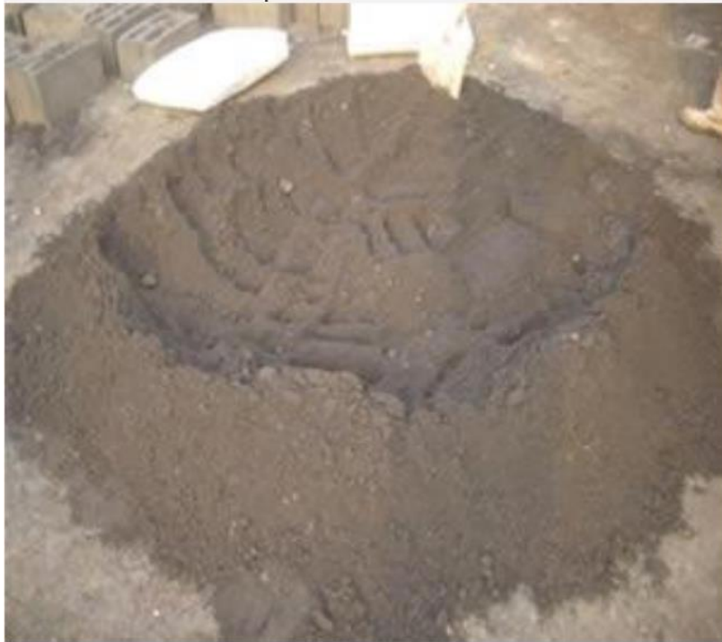
Ilustración 1. Mezclado Manual. Fuente mezcla en el sitio, guiasconcreto.mex.tl
