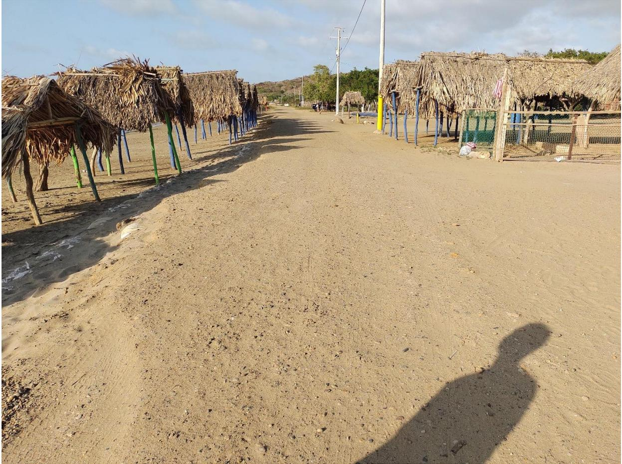
**Figura 18.** Camino compactado de arena y grava, a la izquierda de la imagen se pueden apreciar sacos de arena puestos para ayudar a mantener la integridad física del borde del camino. Fuente: Autor, 2021.
