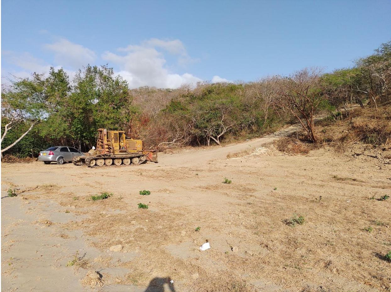
**Figura 22.** Compactación del suelo utilizando un bulldozer para el establecimiento de un camino que conecta con la carretera principal. Fuente: Autor, 2021.
