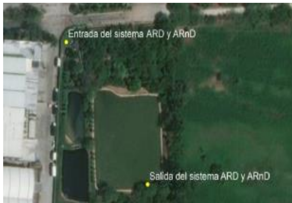
Figura 2 Localización general e imagen satelital del Parque Industrial Malambo S.A y sistema de Tratamiento
