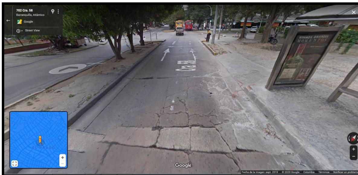
**Figura 64: Daño estructural vía, Calle 72 carrera 53.**
