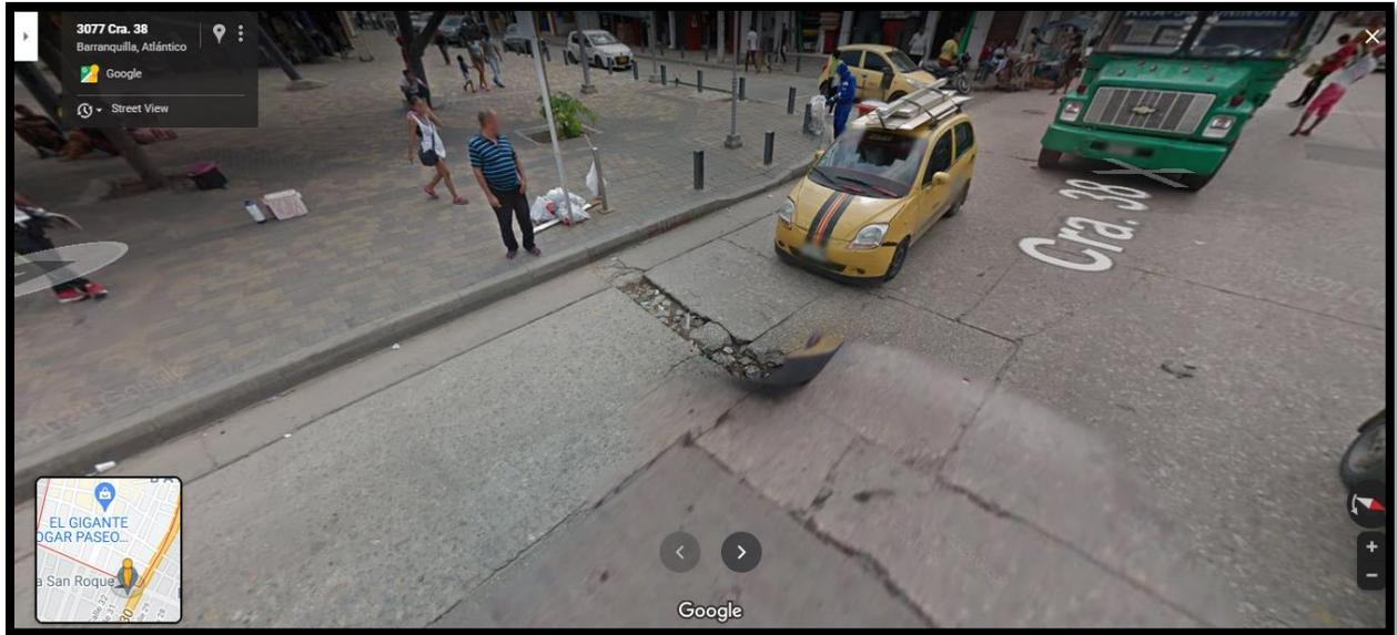
Figura 89: Carrera 38, daño en vía vehicular.
