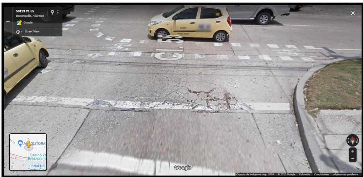
**Figura 75: Daño estructural, calle 55.**
