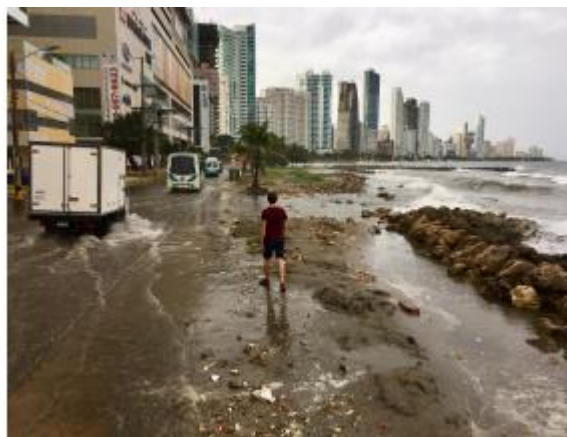
Figura5. Malecón en mal estado, Fuente ( Brakel, y otros, 2017)
