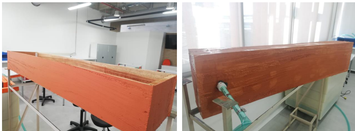
Figura 4. Impermeabilización del canal con impermeabilizante acrílico fibra 12 TOPEX.
