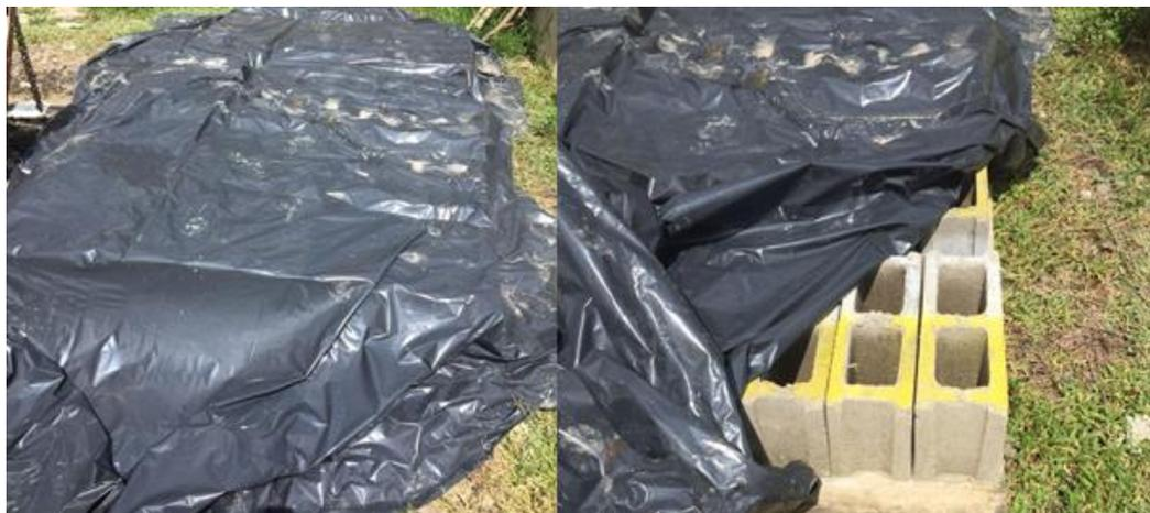
*Nota.* En la figura se muestra el proceso de curado de los bloques, en el cual fueron cubiertos para evitar la evaporación directa del agua. Elaboración propia, 2021.
