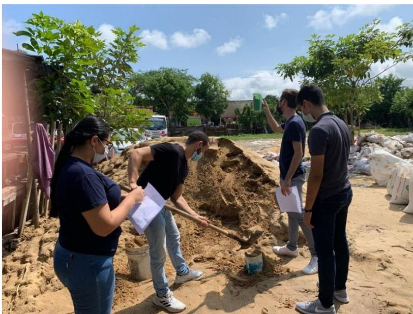
*Nota.* En la figura se muestra el proceso de dosificación en campo, en el cual se utilizaron elementos de medición de volumen controlados. Elaboración propia. 2021.
