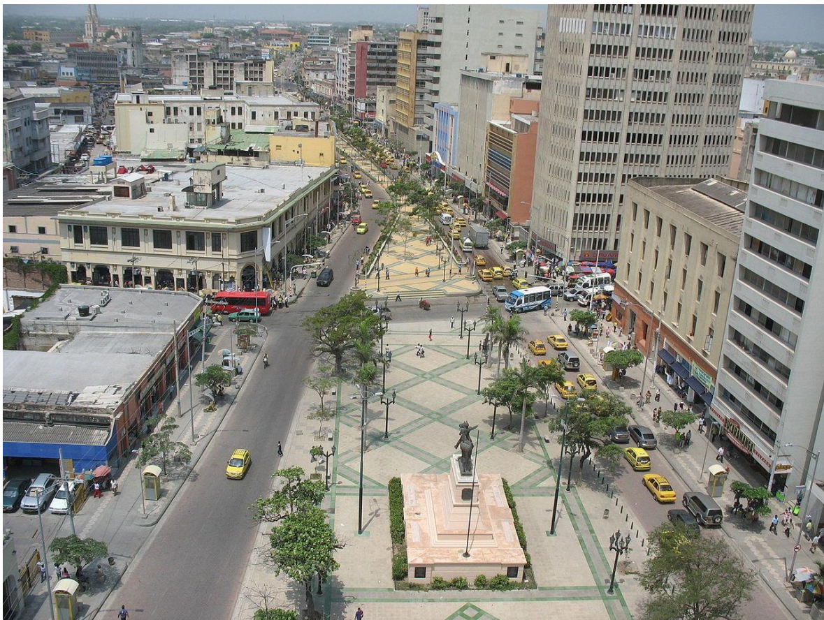
Figura 17. Paseo Bolívar después de la intervención. Tomado de Villalobos (2013).
