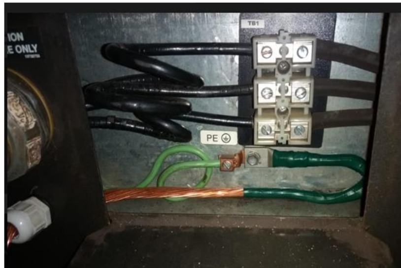
Figura 0.13 Instalación de tierras mesas de corte 2/2. Elaboración propia, 2022.
