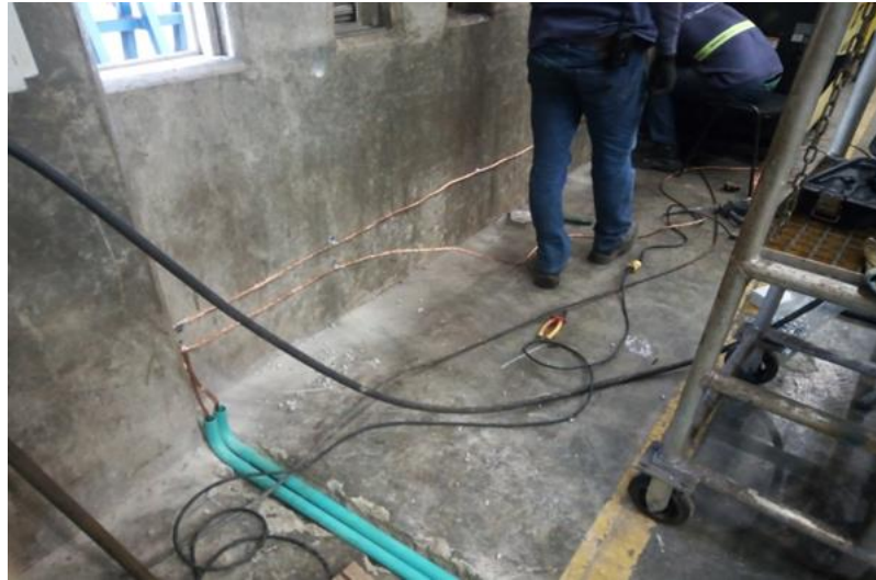
Figura 0.12 Instalación de tierras mesas de corte 1/2. Elaboración propia, 2022.
